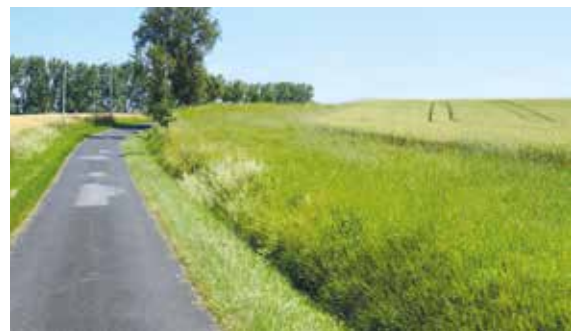
Bande enherbée en haut de talus routier
