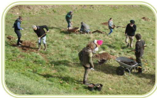
Chantier participatif à Carlucet
