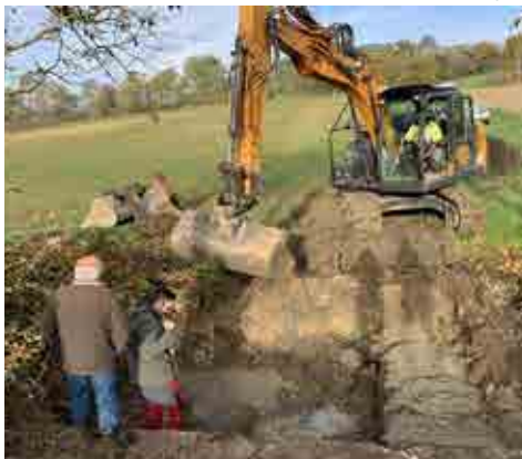
Restauration de la mare bâtie de la Sabatarie (Viviers-les-Montagnes)
